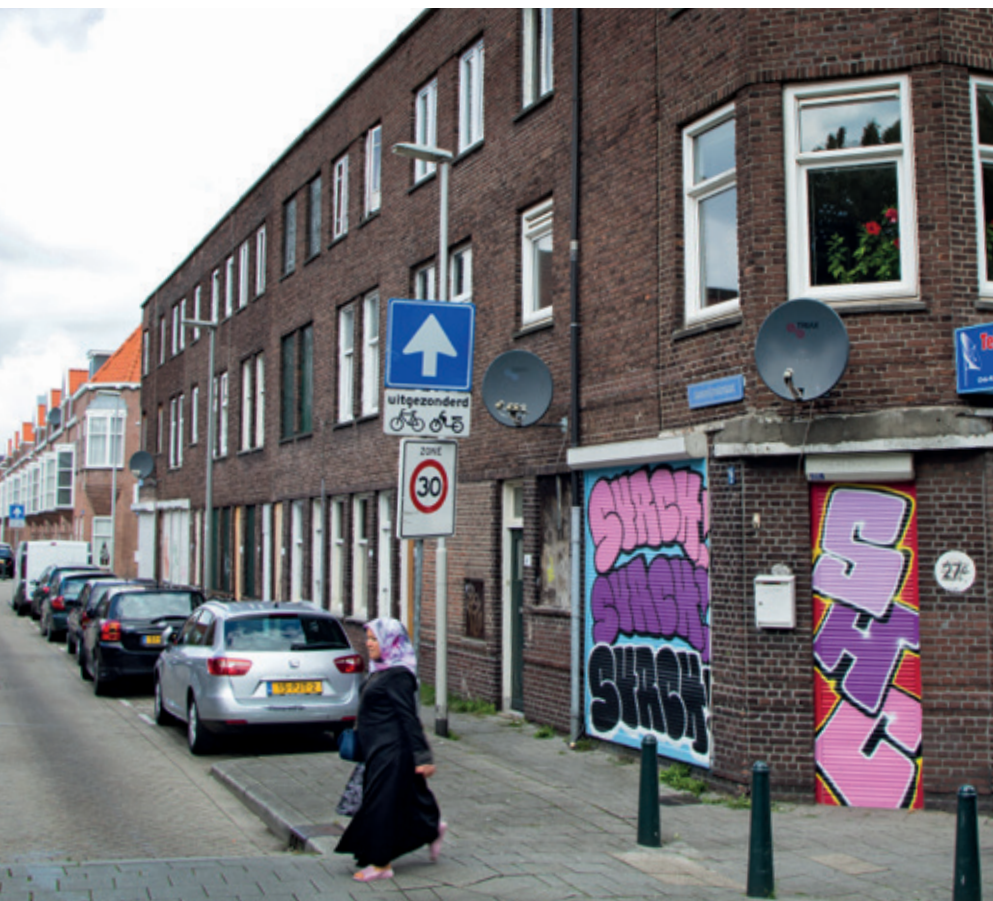
Een huizenblok aan de Dahliastraat dat gesloopt gaat worden voor nieuwbouw van sociale huurwoningen.
